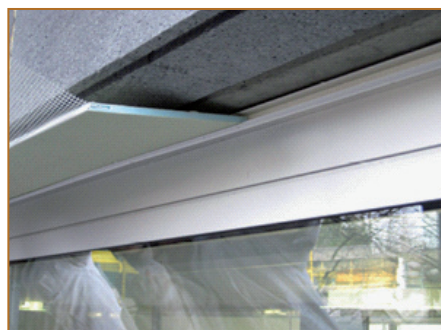
Zasunutí systémové desky do připojovacího profilu
