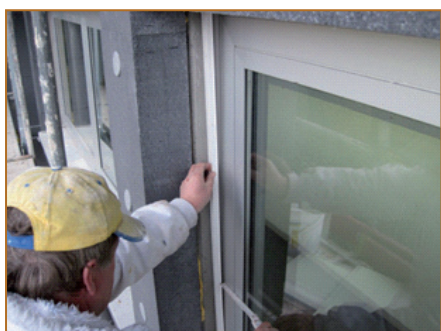
Nalepení připojovacího profilu na okenní rám
