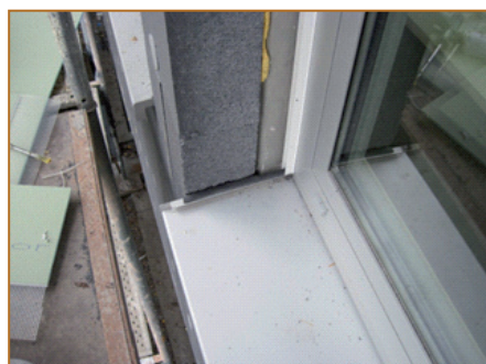
Profil připravený pro zasunutí systémové desky
