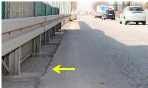
Obr. 11 Sběr odtoků dešť. vodv a nerozpuštěných látek ve zkušební stanici Derchingerstrasse
