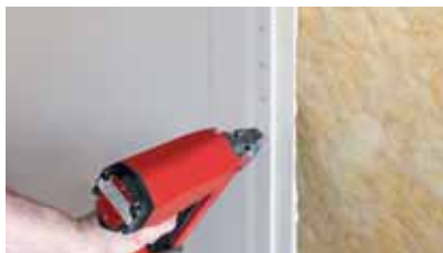
Připevnění desky RigiStabil sponkami k dřevěnému trámku
