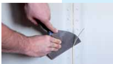
Seřiznutí lepidla po jeho vytvrdnutí (cca 24 h)
