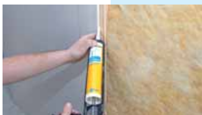
Nanesení polyuretanového lepidla na hranu desky RigiStabil
