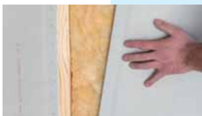
Přiložení další desky RigiStabil natěsno tak, aby spára byla max. 1 mm
