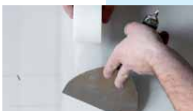
Přetmelení spáry s výztužnou páskou
